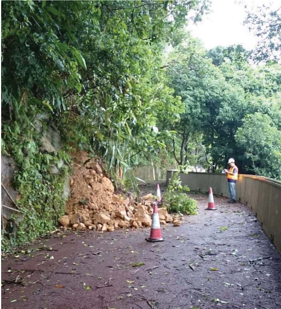
圖 3.3.10 在妮姐的影響下，白加道發生山泥傾瀉。(相片由土力工程處及土木工程拓展署提供)
