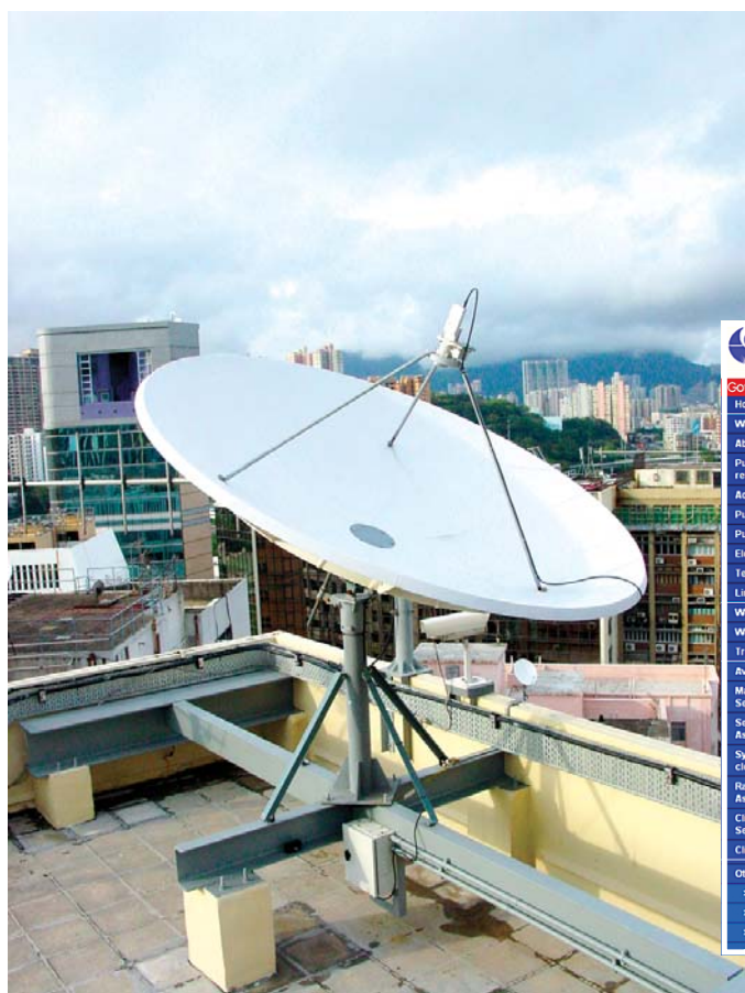
圖一：位於天文台總部的「風雲衛星數據廣播系統」接收天線
