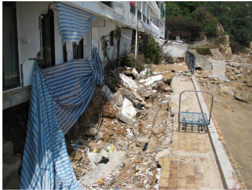
圖五 長洲部分臨海房屋的地台因地基砂石隨潮水流失而下陷
