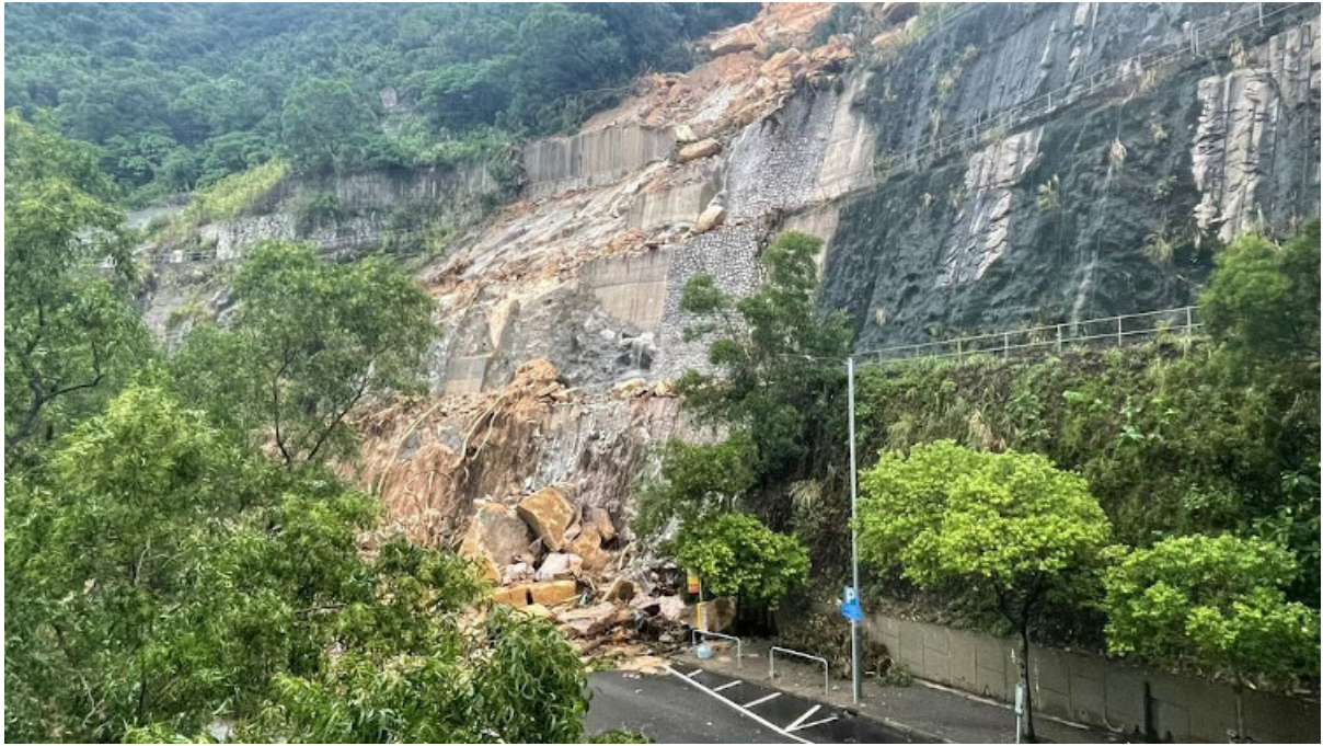
圖 1.7 2023 年 9 月 7 日至 8 日暴雨期間筲箕灣出現山泥傾瀉 (鳴謝相片來源：商台新聞) Figure 1.7 Landslide in Shau Kei Wan during the rainstorm on 7 – 8 September 2023 (Courtesy of CRHK News)
