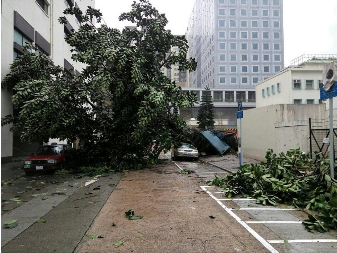
圖 2.4.7 荔枝角消防局附近有樹木被吹倒。(照片由市民提供)
