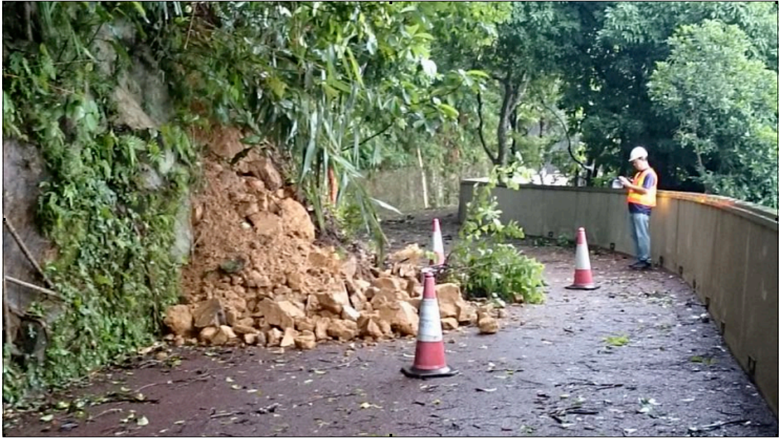
圖 1.1 妮姐吹襲香港期間，白加道發生山泥傾瀉。(相片由土力工程處及土木工程拓展署提供)
