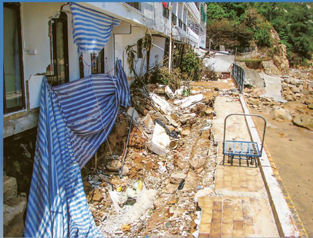
在黑格比影響下，鰂魚涌的最高潮位為3.53米，是自一九六二年溫黛影響香港以來最高記錄。而黑格比引起的風暴潮在長洲東灣侵蝕了臨海房屋的地基（圖片由黃永德博士提供）。
