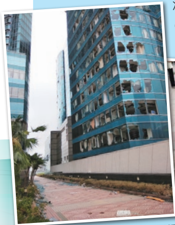
紅磡有大廈玻璃幕牆嚴重破損
