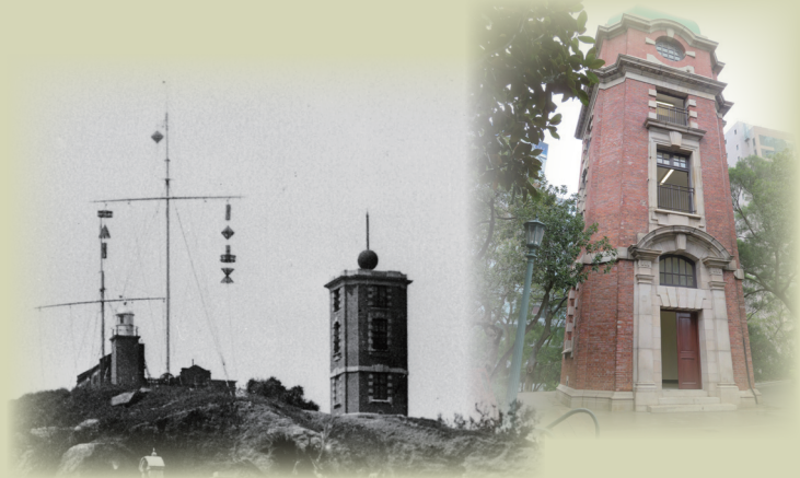
黑頭角訊號塔昔日（左）與現貌（右）的比較
