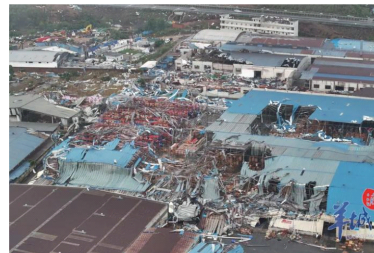
圖19 2024年4月27日廣州市白雲區鐘落潭鎮附近工廠廠房被龍捲風吹翻（圖引自羊城晚報）
