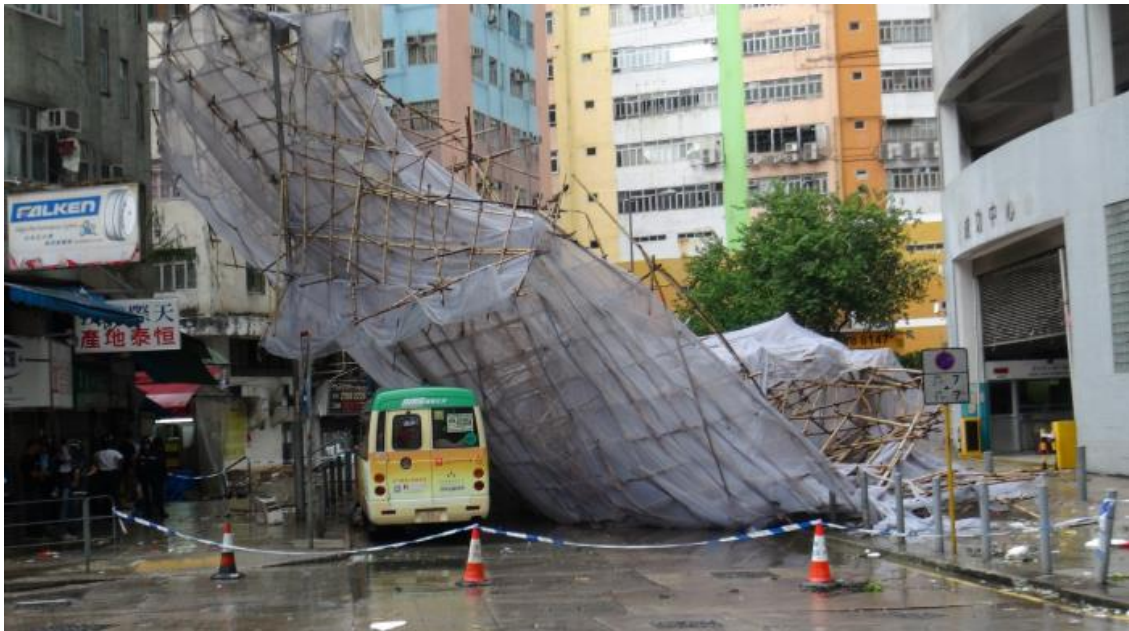
圖 3.4.9 颱風海鷗吹襲期間，葵涌打磚坪街有一幅棚架倒塌，導致一輛貨車及一輛小巴損毀(相片由星島日報提供)。
