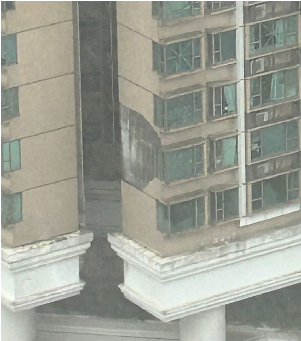
圖 3.11.18 樺加沙襲港期間，深井有住宅大廈外牆牆磚剝落。(鳴謝：CY)
