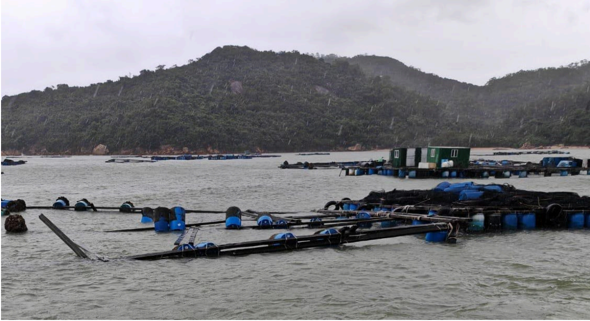
圖 3.11.37 樺加沙襲港期間，大嶼山長沙灣有魚排設施遭風浪影響而受損。(鳴謝：漁農自然護理署)
