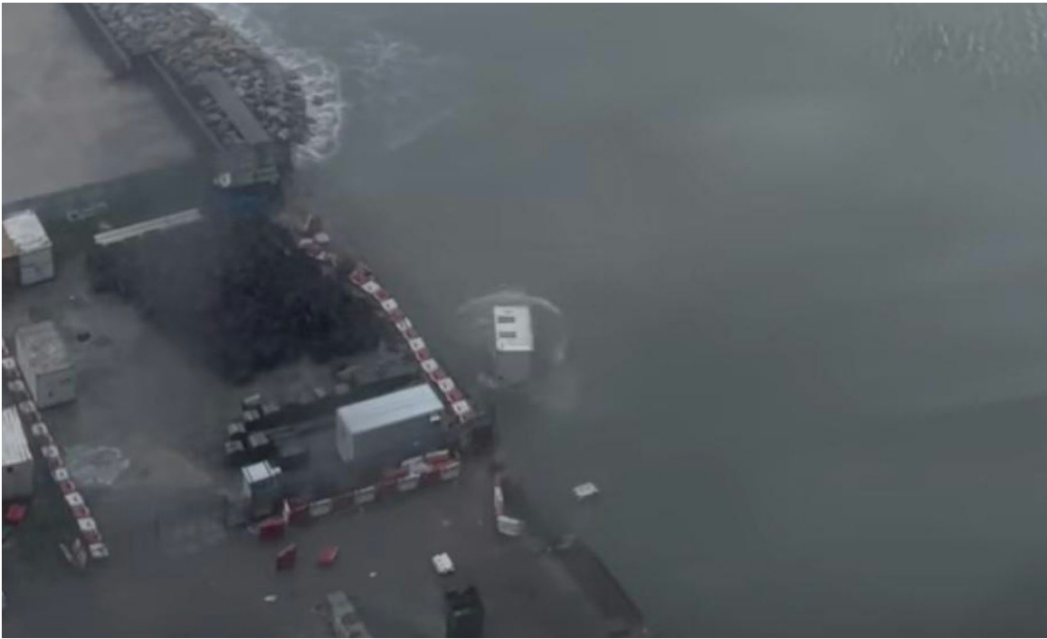
圖 3.11.19 樺加沙襲港期間，將軍澳有地盤貨櫃遭強風吹落海中。(鳴謝：一市民)
