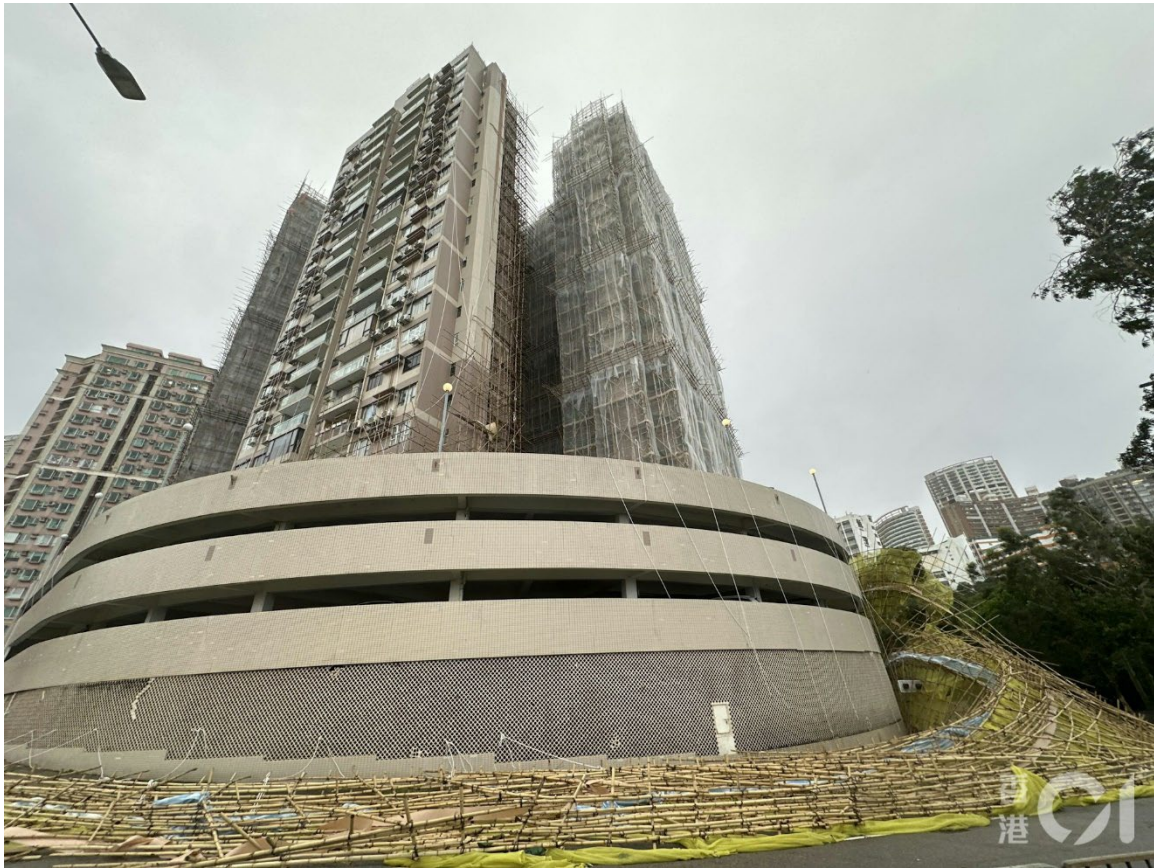
圖 3.4.13 韋帕襲港期間，北角有停車場的一幅100米乘20米外圍棚架倒塌，壓住對開的四條行車線。(鳴謝：香港01 / 黃學潤攝)
