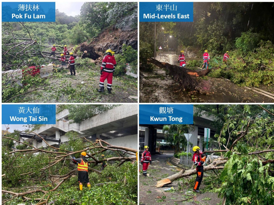
圖 3.11.12b 樺加沙襲港期間，本港有多條路段因塌樹需要封閉。(鳴謝：消防處 (左上、右上及右下)及路政署(左下))
