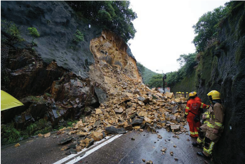
圖 1.2 赤柱大潭道一幅護土牆在六月十三日的一場暴雨下倒塌 (照片由土力工程處及土木工程拓展署提供)
