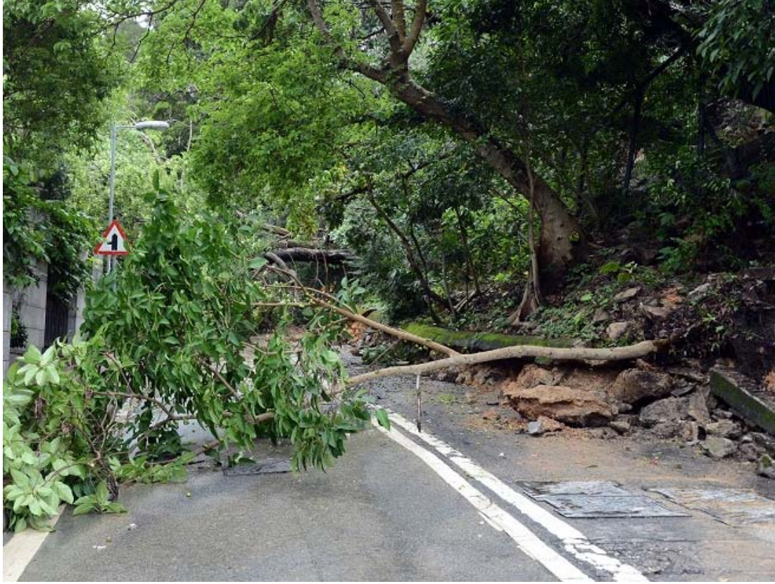
圖 1.4 在2014年5月12日早上，壽臣山道路旁有樹木塌下。(相片由星島日報提供) Figure 1.4 Trees beside Shouson Hill Road collapsed on the morning of 12 May 2014 (Courtesy of Sing Tao Daily)
