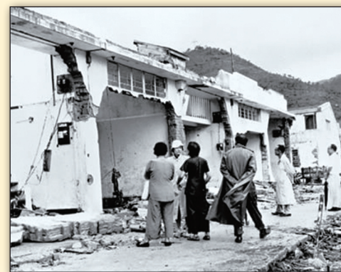
圖一：溫黛襲港，破壞嚴重。（香港歷史檔案館提供）
